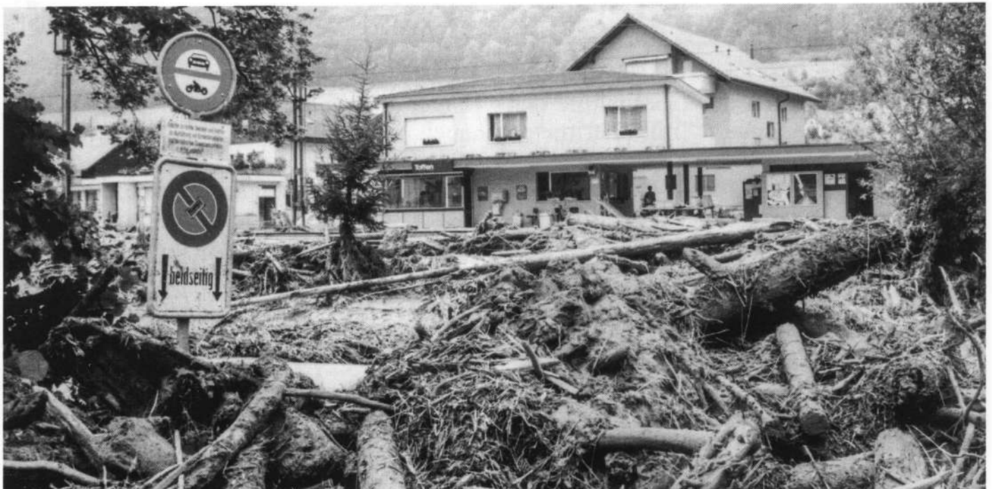
Das durch die Überschwemmung vom 31. Juli 1990 verwüstete Bahnhofareal
