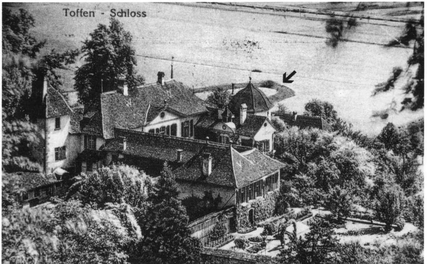
Schloss Toffen 1922 mit sichtbarer Gürbeschleife, wo sich auch nach der Gürbekorrekturektion (1862 – 1865) noch jahrzehntelang Tümpel und Moraste bildeten (siehe Pfeil).
